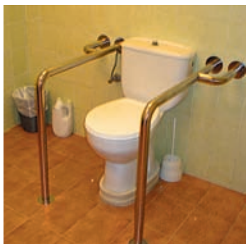
Accesibilidad en los baños: en el primer caso, hay barras fijas que impiden su uso y, en el segundo, hay una disposición de cuarto de baño adaptado
