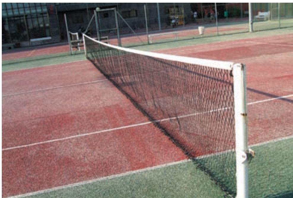
Pavimento de hormigón. Tenis.
